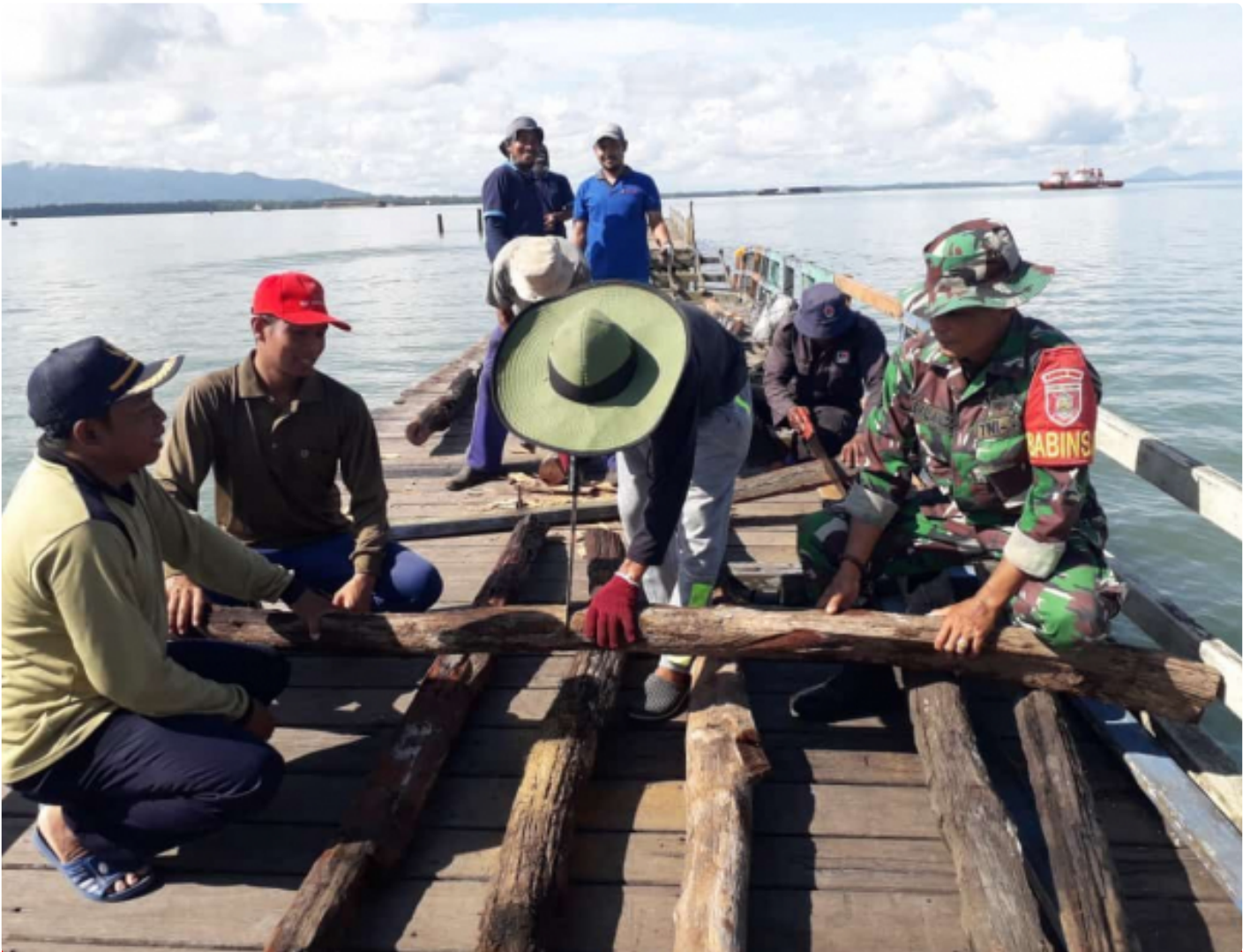
Serka Salahudin Gotong Royong Bersama Warga Perbaiki Jembatan
